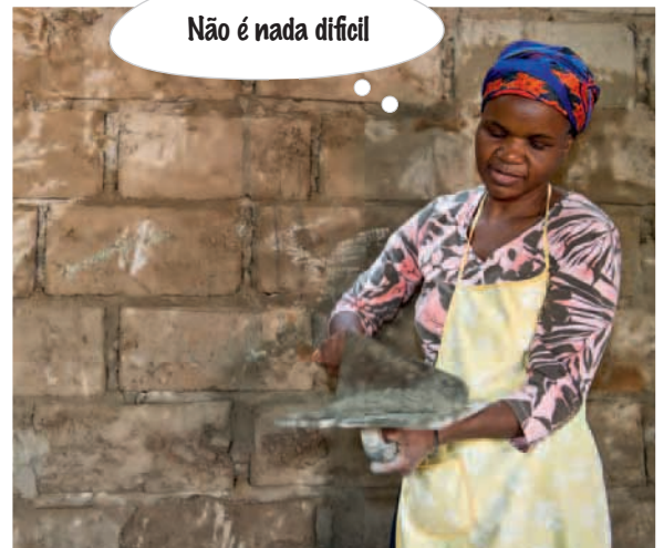
... de pois proporciona a masse em cima da talocha e deceguida remata à parede.
