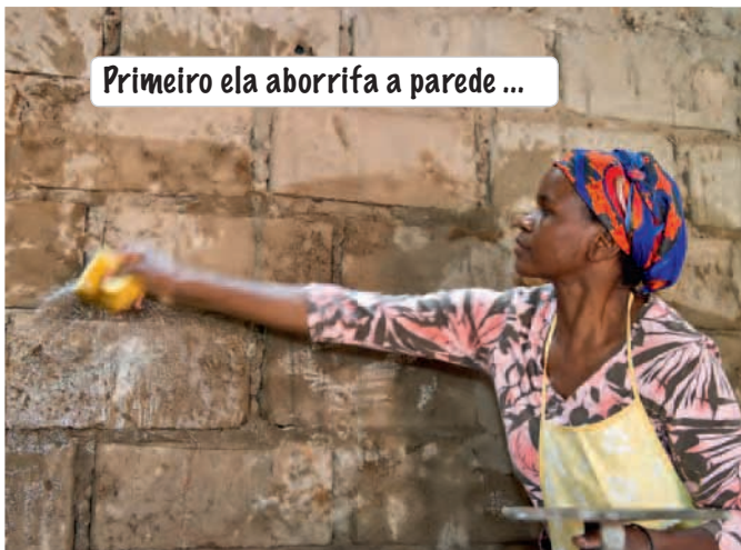
... de pois proporciona a masse em cima da talocha e deceguida remata à parede.
