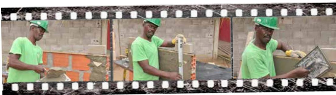
e servindo para tirar a espessura do reboco; em seguida, aplicamos sobre a massa uma pequena peça de azulejo e cortamos cuidadosamente os excessos da massa. Depois medimos a espessura desejada e batemos um pouco para diminuir e obtermos assim a espessura de 2 cm.
