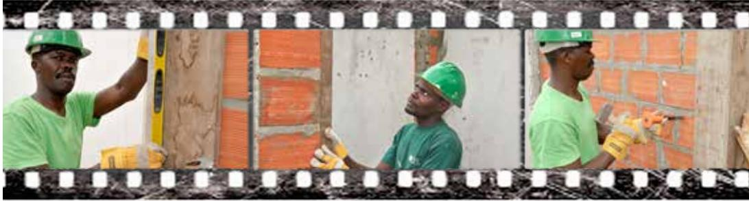
Pegamos no bloco, colocamos massa numa extremidade e pousamo-lo por cima da massa que anteriormente colocámos na fundação; damos uma marteladinha para segurar e repetimos o processo até cobrirmos toda a fiada. De seguida, colocamos a massa nos intervalos para a parede ter resistência e alisamos com a talocha e a colher, tirando os excessos. Medimos os níveis na parte superior e nas laterais para verificar se a parede está nivelada.
