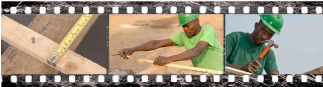
Calculamos o nível do chão, colocando o aparelho de medição por cima da madeira em cada um dos quatro pontos; este processo tem como objectivo definir o nível, a altura e a espessura do chão que se deseja. De cada vez que efectuamos o processo anteriormente mencionado, implantamos um ferro em cada um dos quatro pontos como guia ou marcador. Depois de implantados os ferros nos quatro pontos, voltamos a medir o nível dos mesmos.
