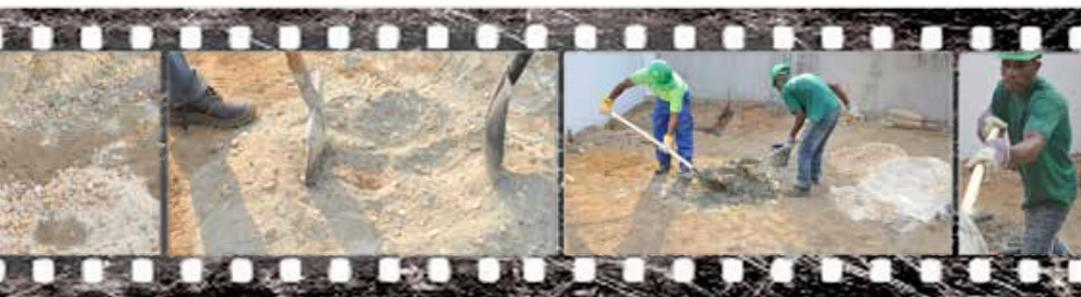
modo a fazer uma abertura no meio. Adicionamos as quatro unidades de burgal e misturamos os dois componentes. Em seguida, adicionamos uma unidade de cimento e misturamos tudo até termos a areia toda acinzentada; depois, fazemos novamente uma abertura no meio, acrescentamos uma unidade e meia de água e continuamos a misturar até obtermos uma massa consistente.
